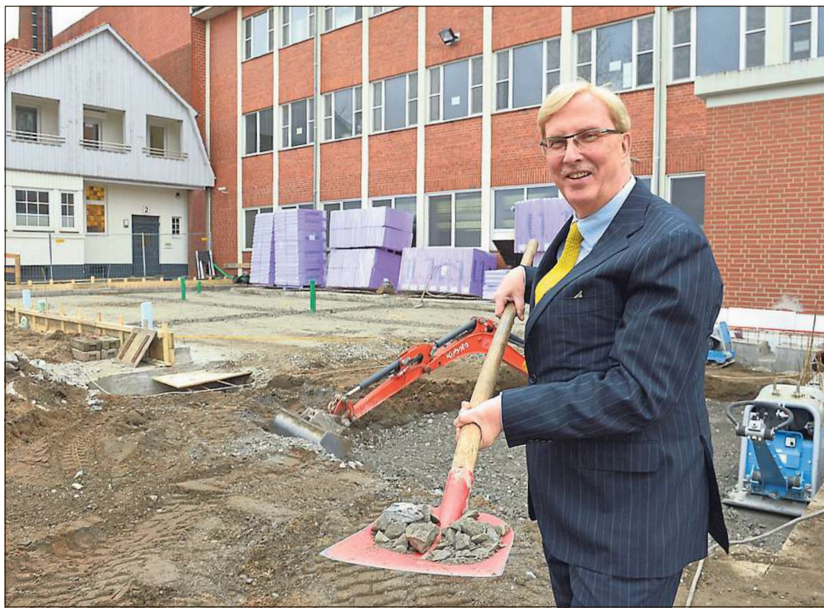
Geschäftsführender Gesellschafter mit Schaufel: Albert Detmers zeigt die Stelle, an der die Bäckerei um einen dreigeschossigen Anbau mit insgesamt 600 Quadratmetern Nutzfläche erweitert wird. Bild: Dünhölder
