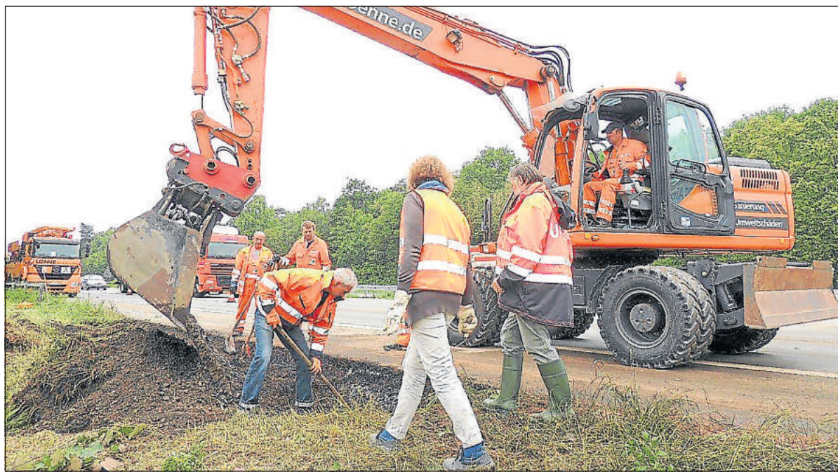
Sanierungsarbeiten nach dem Tanklastereinfall: Mit einem Bagger wurde der Boden auf dem Grünstreifen abgetragen. Die Arbeiten werden voraussichtlich bis Mittwoch andauern. Bilder: Darhoven
